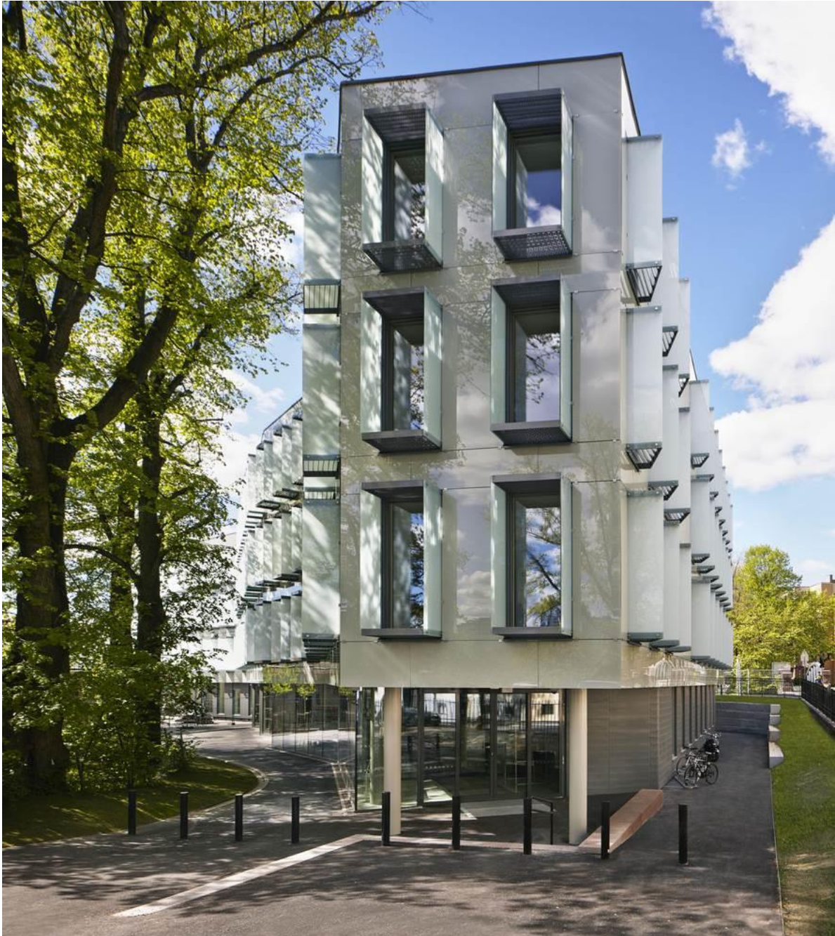
Joonis 3.11 - Munkendamsveien 62 büroohoone varjestamine. Autorid: LPO arkitekter. Digitaalne allikas: https://www.archdaily.com/867849/munkedamsveien-62-lpo-arkitekter . Foto: Ivan Brodley
