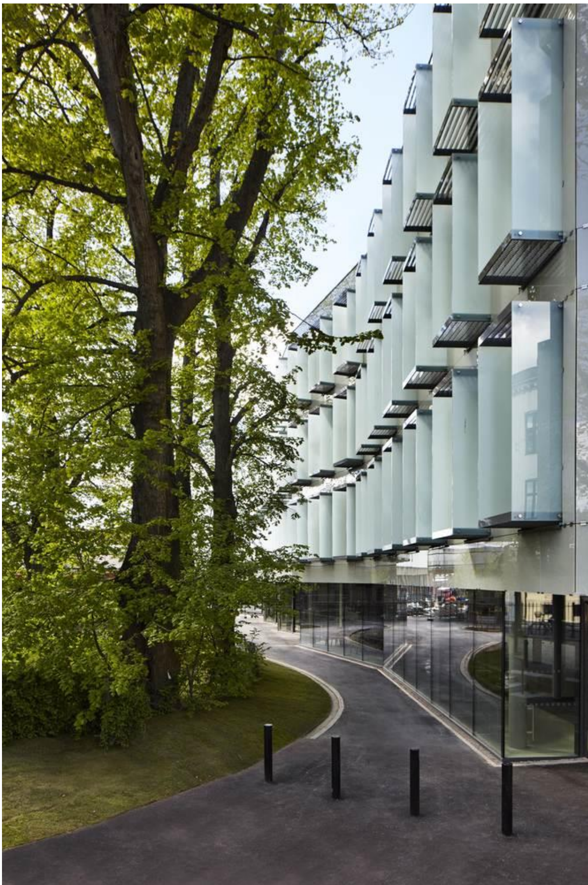
Joonis 3.10 - Munkendamsveien 62 büroohoone varjestamine. Autorid: LPO arhitektid. Digitaalne algallikas: https://www.archdaily.com/867849/munkedamsveien-62-lpo-arkitektid . Foto: Ivan Brodley
