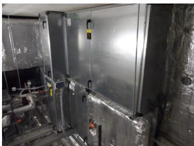
Joonis 2.10 Rotorsoojusvahetiga ja vesikalorifeeriga ventilatsiooniagregaat
