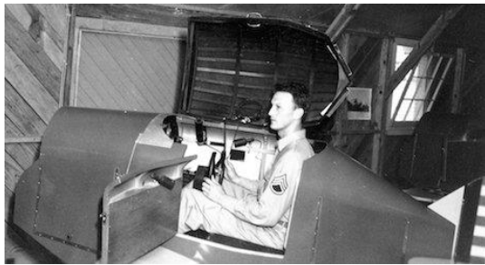
Foto 4. Linki treeningsimulaator [7]
