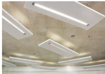
Hoonel pole traditsioonilist ripplage, vaid akustilised paneelid, millesse on süvistatud valgustid. Sellised paneelid võimaldavad betoonsüdamikule soojust kasutada sisekliima reguleerimiseks. Foto: Royal HaskoningDHV
