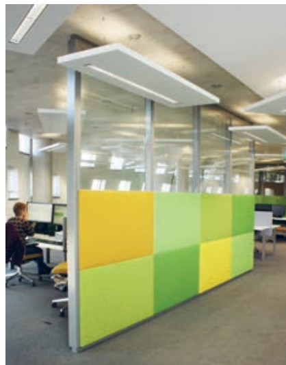
Vaheseinad jagavad avatud kontori väiksemateks osadeks. Vaheseina alumine osa koosneb heli neelavatest paneelidest. Ülemine osa on klaasitud, mis aitab säilitada muljet avatusest ja võimaldab päevavalgusel tungida hoone sisse. Foto: Royal HaskoningDHV
